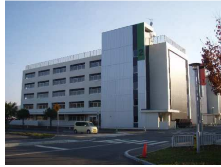
団地外部（2号棟側）
